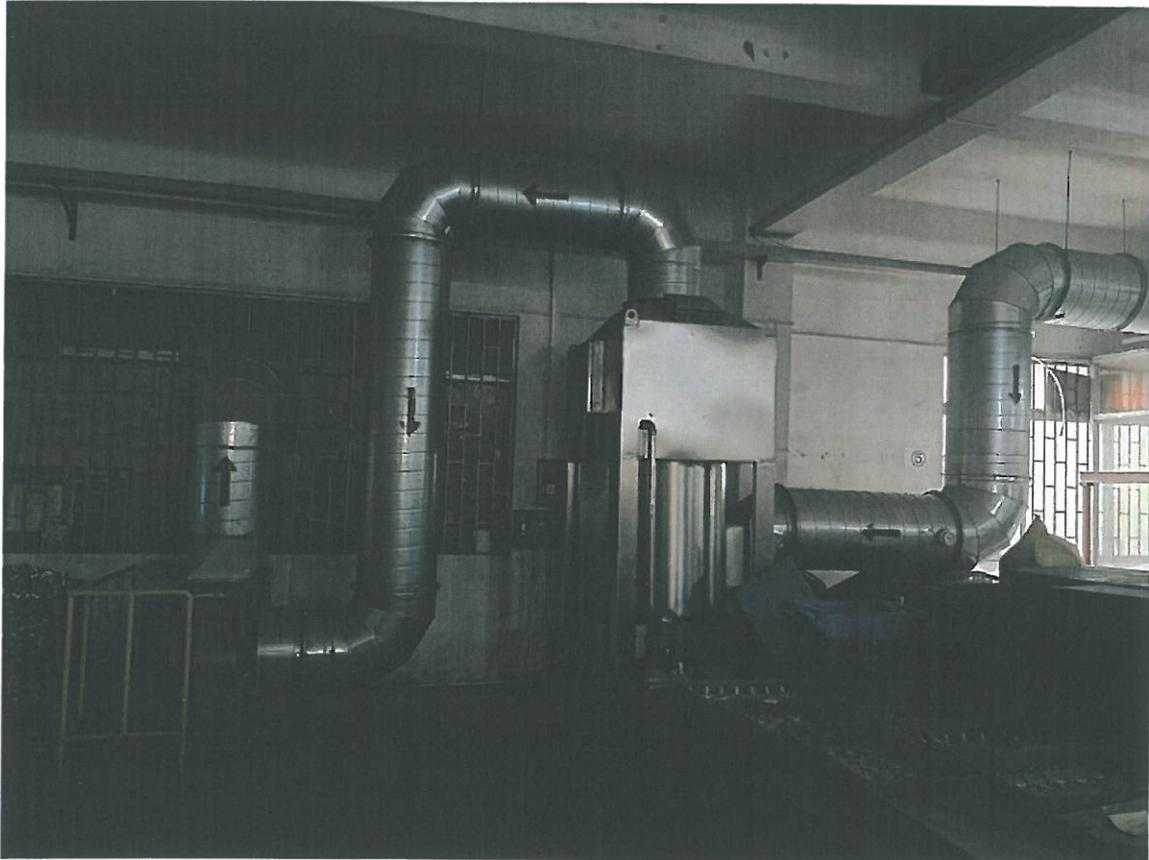
图 3-5 废气治理设施（水喷淋装置）
